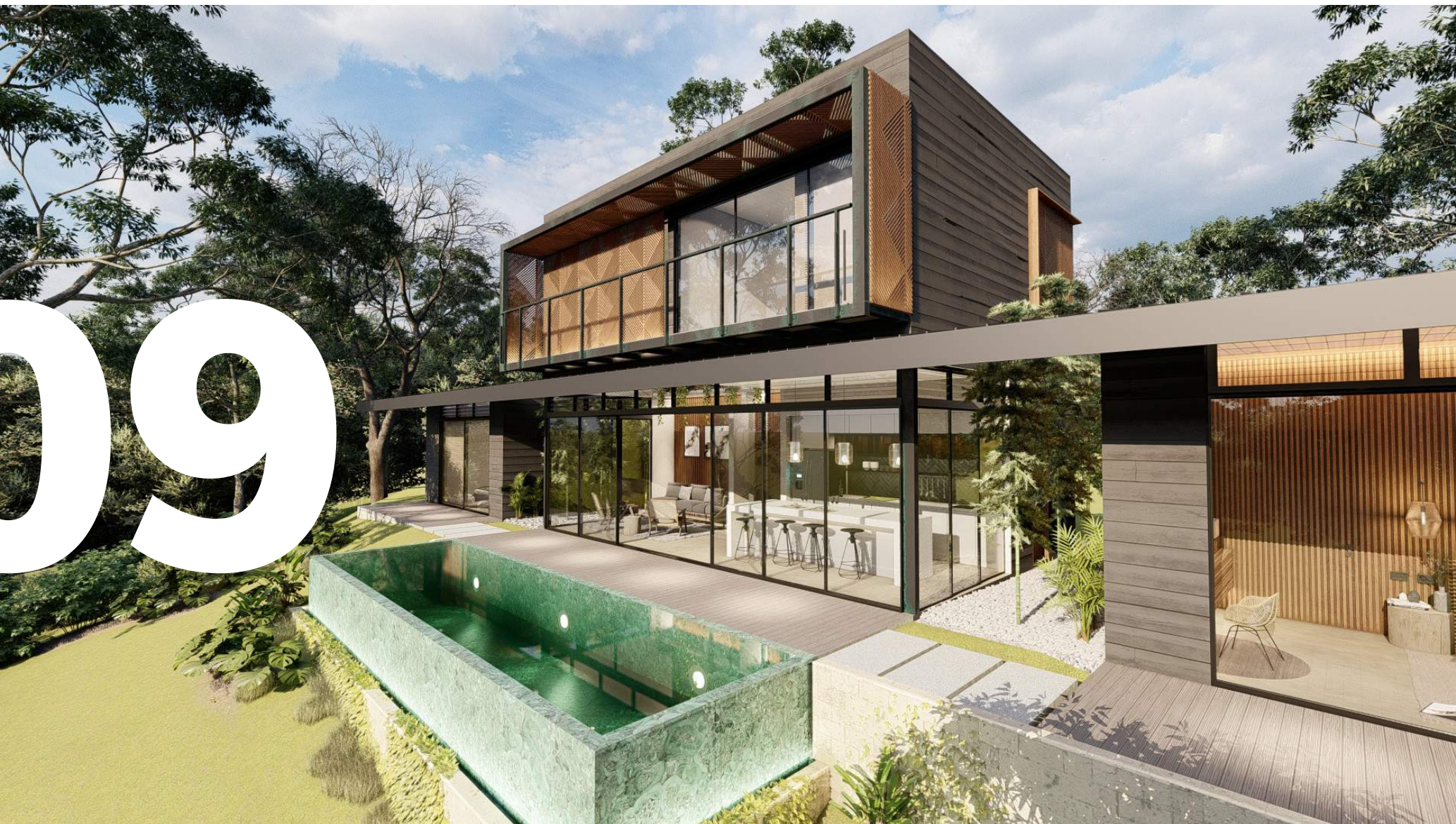
01_Image: Photography of rear facade / Fotografía de la fachada posterior
