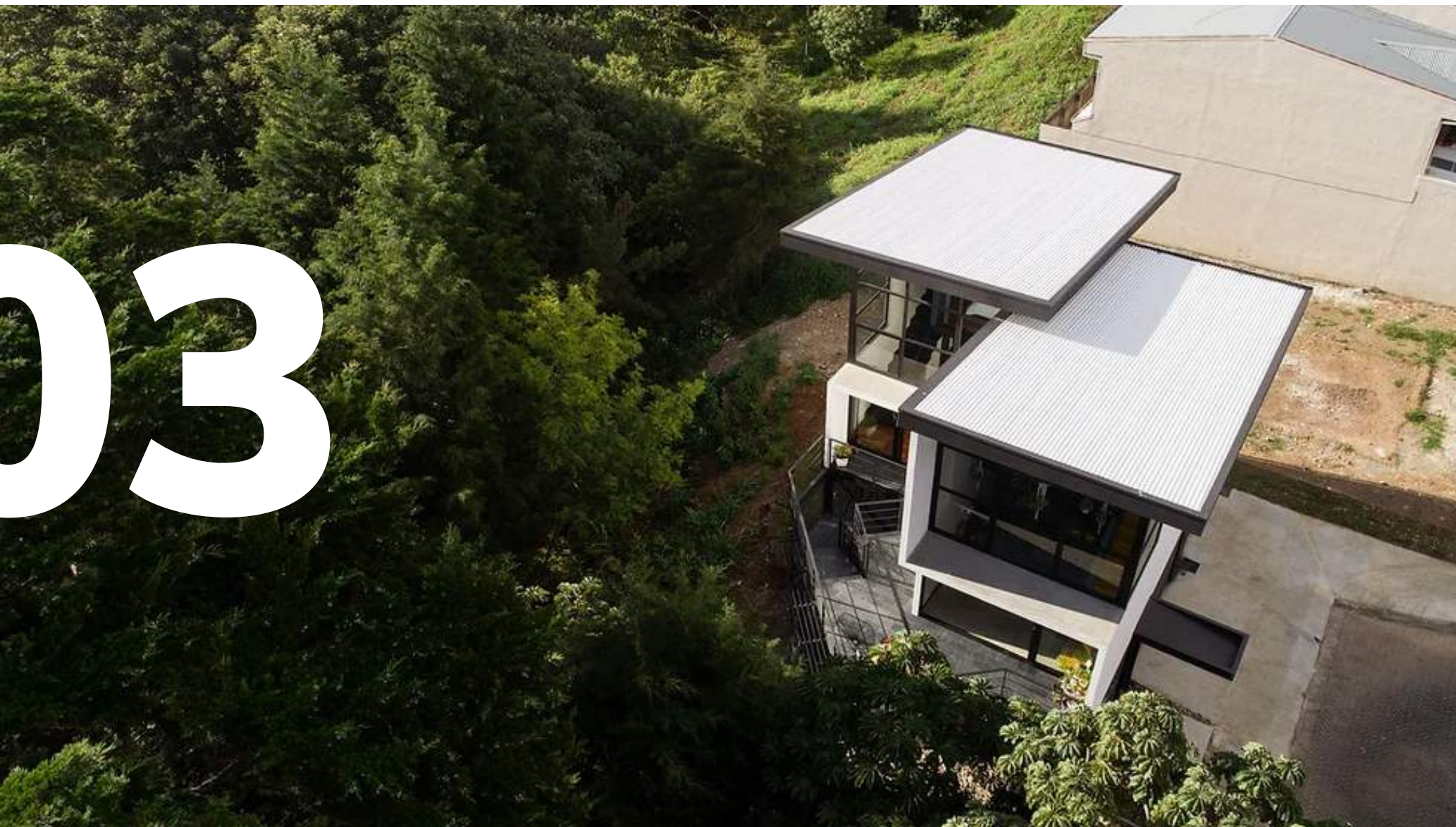
01_Image: Aerial Photography of Apartaments / Fotografía aérea de los Apartamentos
