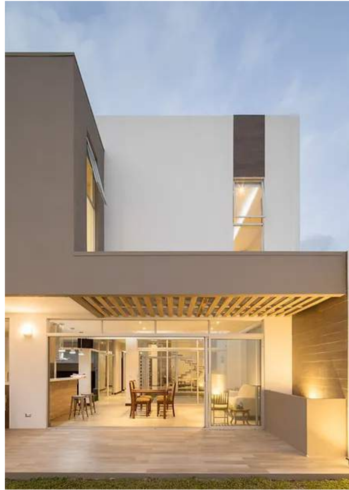
07_Image: Photograph of the rear facade / Fotografía de la fachada posterior
