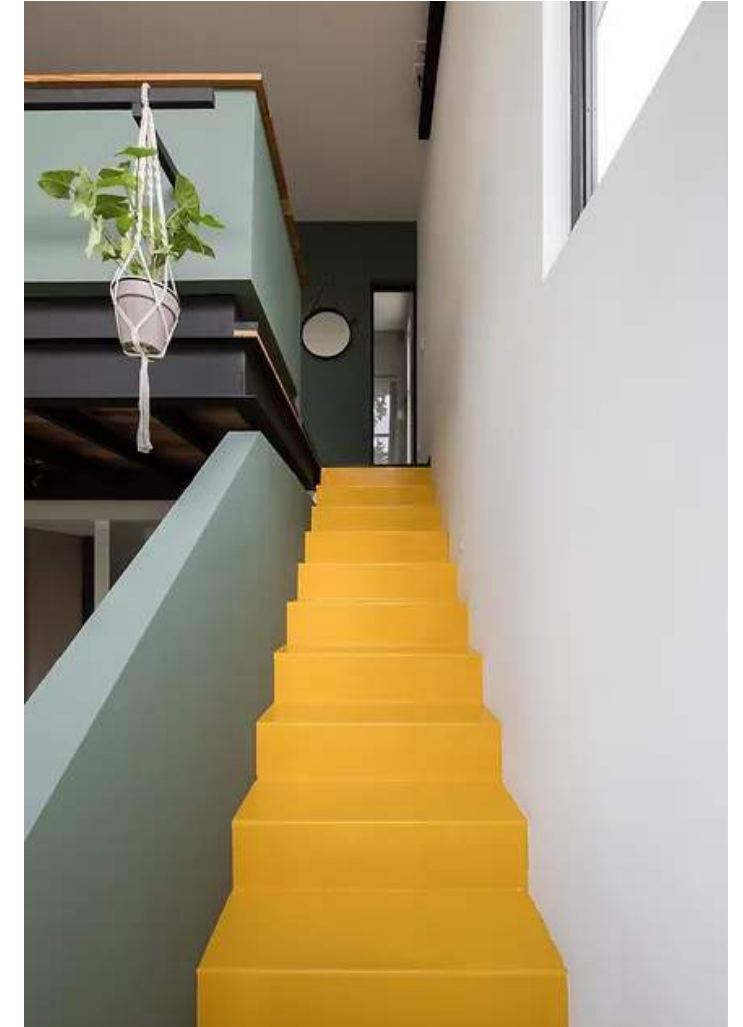
09_Image: Photograph of metal stair of left apartment / Fotografía de la escalera de metal
