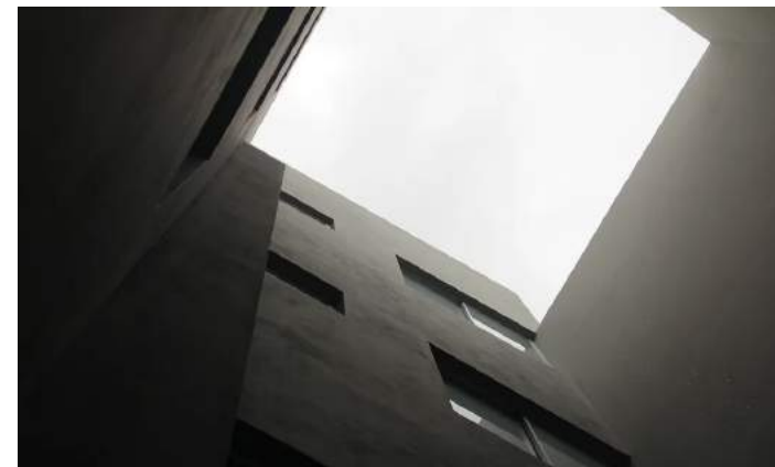
04_Image: Photograph of central yard / Fotografía de patio central
